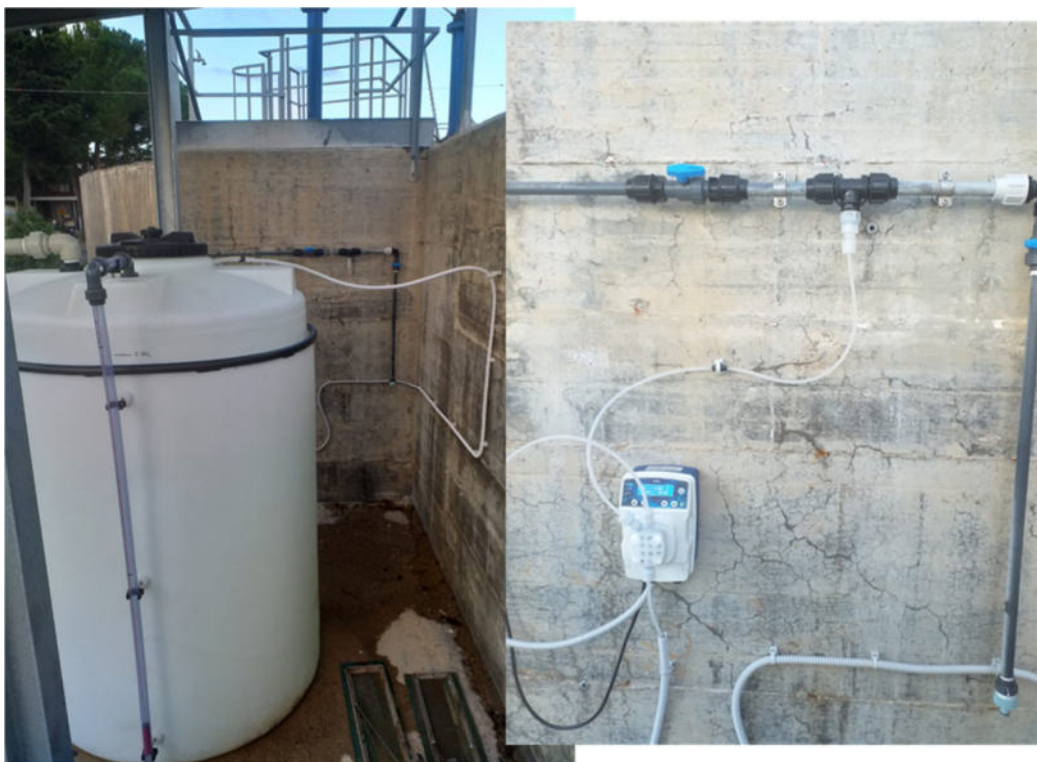
Fig. 6. Stazione di stoccaggio acido peracetico
